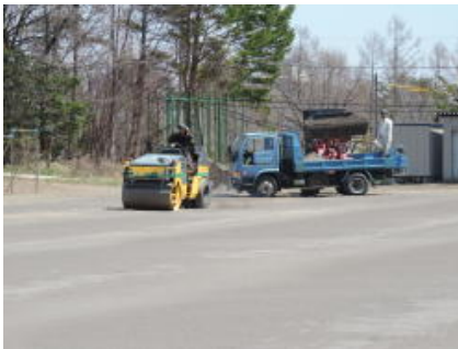
てん圧作業中
