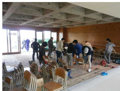
←玄関での 解体作業
