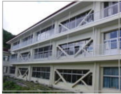
耐震補強工事
