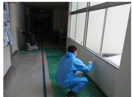
廊下の塗装作業の様子
