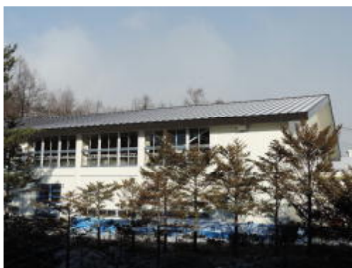
外回りは完成（体育館）
