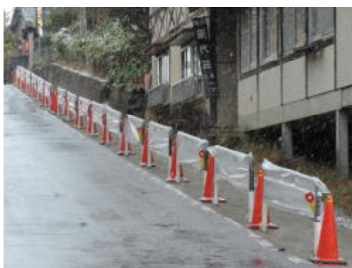
工事も急ピッチ！
