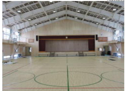
明るく、きれいな体育館となりました。
